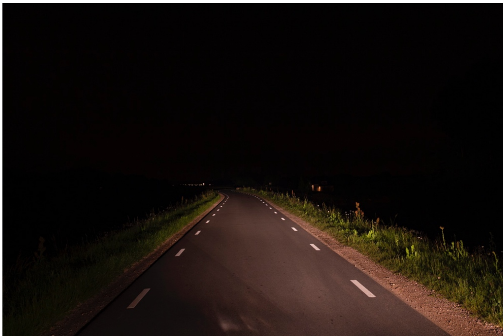
Foto: Rijnbandijk in Ingen, belijning voor het verloop van de weg.
