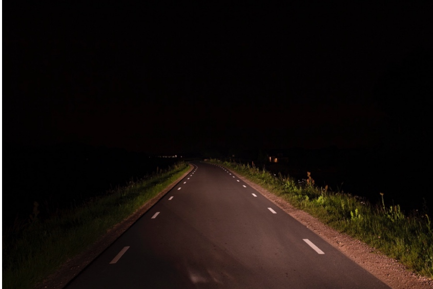
Foto: Rijnbandijk in Ingen, voorbeeld van markering. Belijning geeft het verloop van de weg weer.
